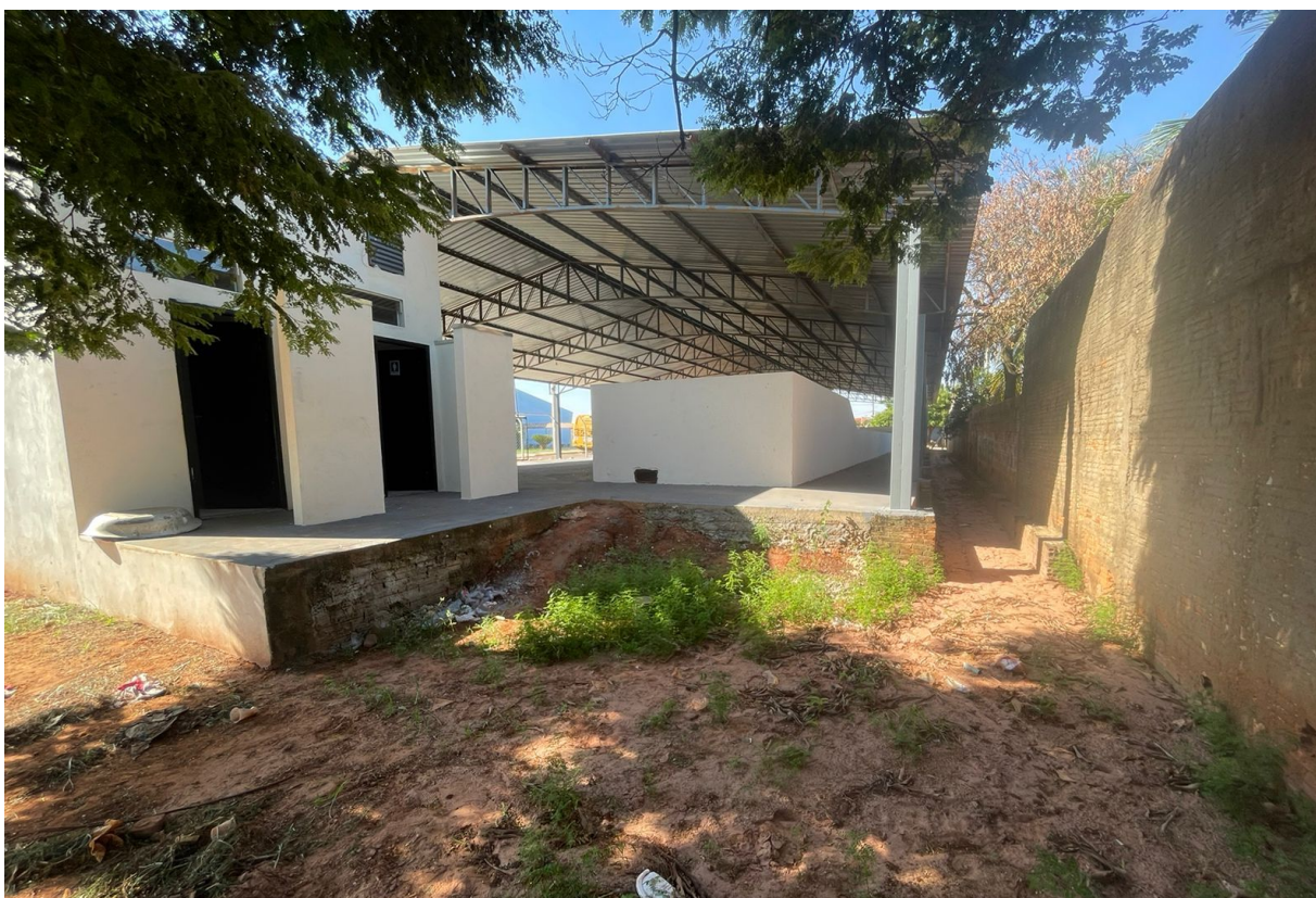
Foto 08 – Entrada dos banheiros
