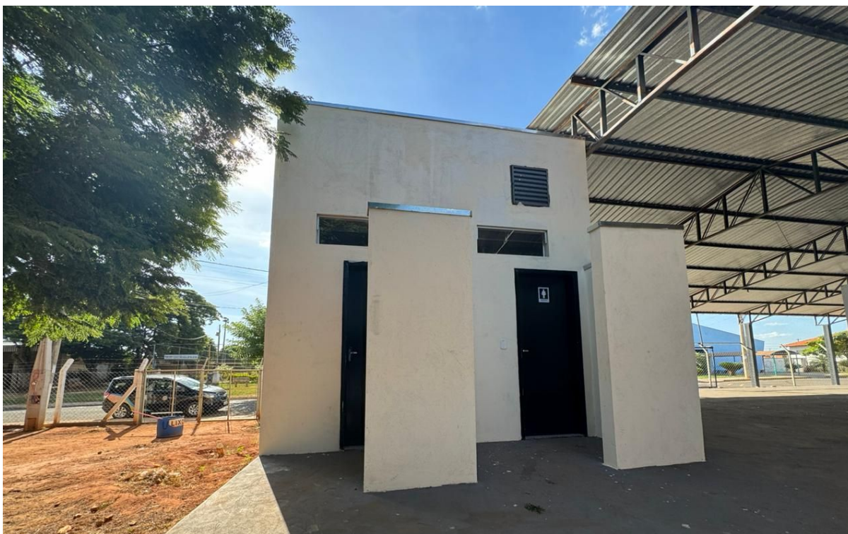
Foto 10 – Entrada dos sanitários
